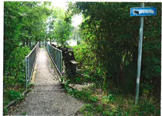
Abb. 3.20 Fussgängerbrücke am Zopfweg
