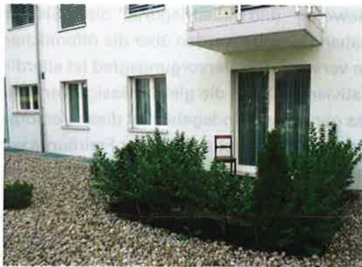
Abb. 3.28 Alte Gasse gegenüber Rest. Dietiker Strassenseitige "Gestaltung" an zentraler Lage.
