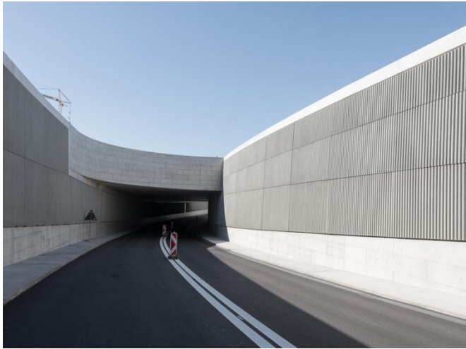
Abbildung 24 Referenzbild für Sichtbetonsockel und grauen (nicht Anthrazit-farbigen) Lavabeton. Limmattalbahnhof Los 6, Bild: DSP.
