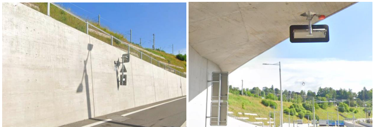
Abbildung 32 Signalanlagen Galgenbuck Tunnel, Neuhausen, die Rückseiten sind einheitlich aus feuerverzinktem Stahl (Bild Google Streetview).
