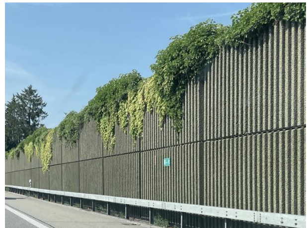
Abbildung 41: Referenzbild einer von oben bepflanzen Lavabetonwand (Autobahn A1, Kriegstetten, Bild LI). Im Projekt VERAS ist eine Bepflanzung von unten und oben vorgesehen.
