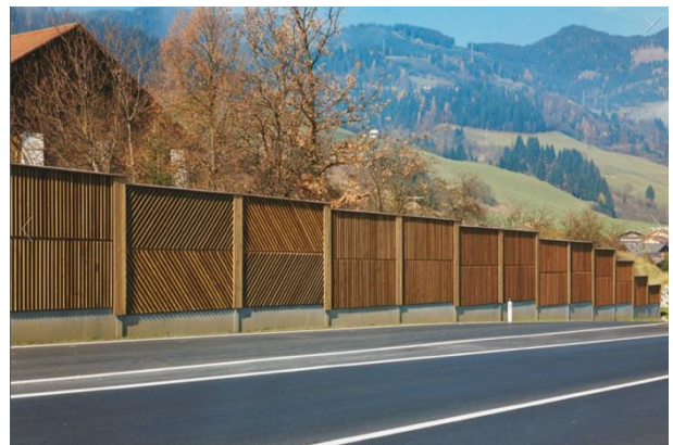
Abbildung 49: Schlechtes Beispiel: Viele Versprünge, unterschiedliche Lattungen, zu viel Ornament, unnötig auffällige Gestaltung
