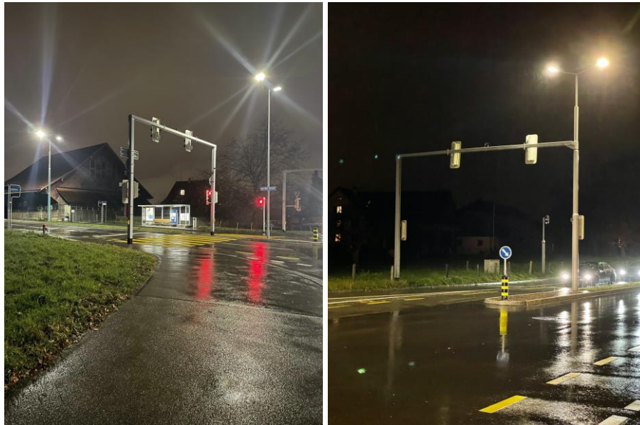
Abbildung 61: Synergien nutzen: a) schlechtes Beispiel: Kandelaber und LSA separat; b) gutes Beispiel auf Kandelaber auf LSA-Portal montiert. (Bilder L. Ingold)
