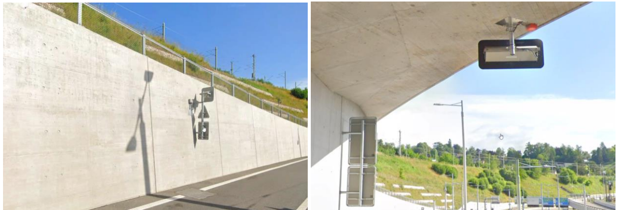
Abbildung 63: Signalanlagen Galgenbuck Tunnel, Neuhausen, die Rückseiten sind einheitlich aus feuerverzinktem Stahl (Bild Google Streetview).
