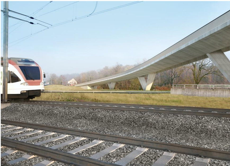
Abbildung 26: Überführung B-178: Ansicht aus dem rückgebauten Bahnübergang in Richtung des Widerlagers Nord (Visualisierung Projekt INTEGRAL)
