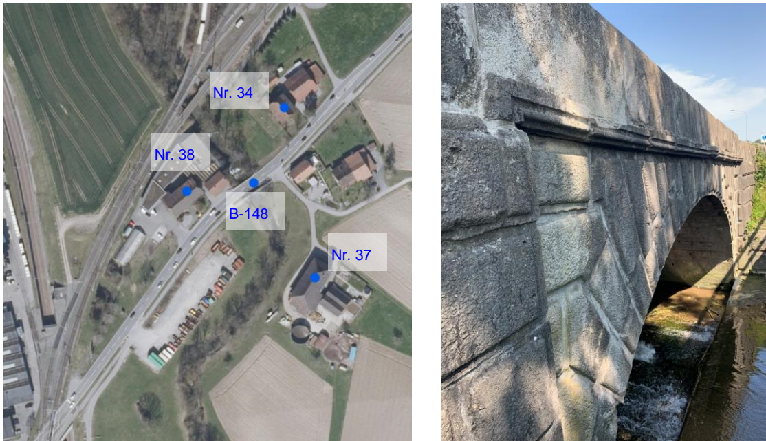
Abbildung 21: Denkmalgeschützte Objekte im Teilprojekt 1: Links: Häuser Nr. 34, 37 und 38 sowie Alte Wynabrücke B-148 Rechts: Alte Wynabrücke von Süden. Die Schwelle für die Hydrometrie-Messstelle FG-0348 ist im Bild rechts erkennbar.
