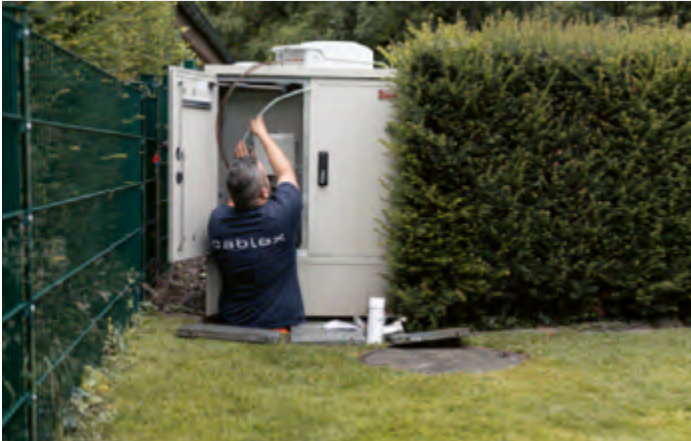
Insgesamt wurden 603 km Glasfaserkabel verlegt.
