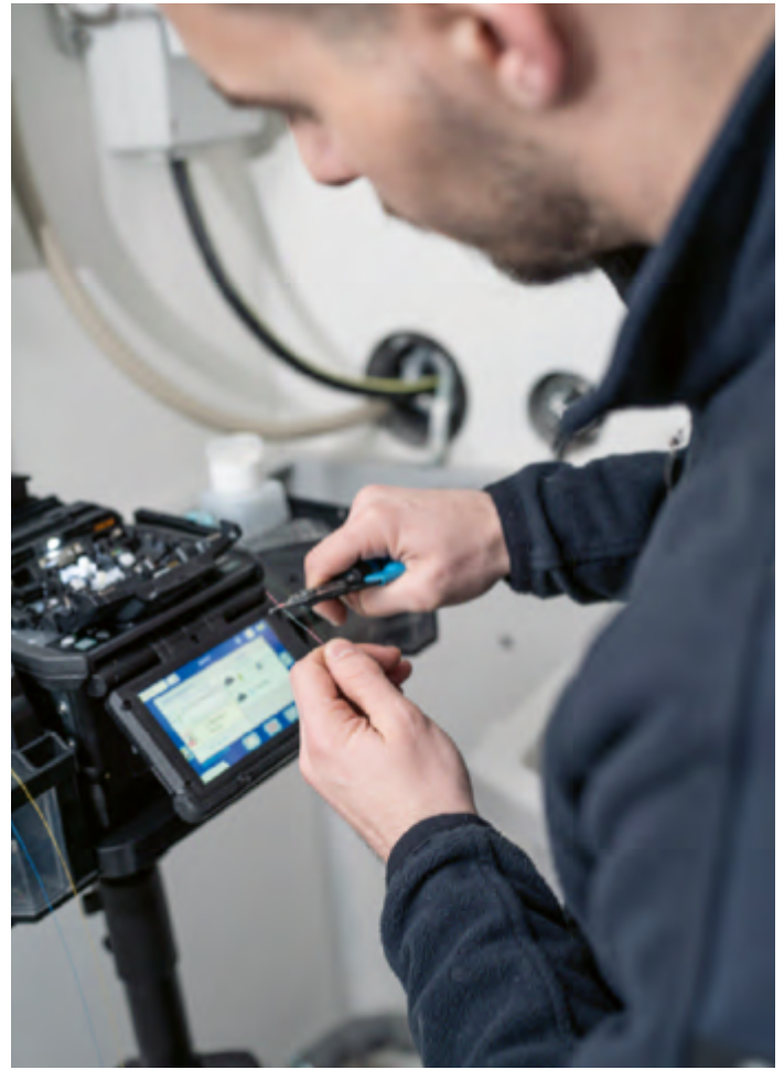
Der Glasfaserausbau erforderte viel Spleissarbeit.
