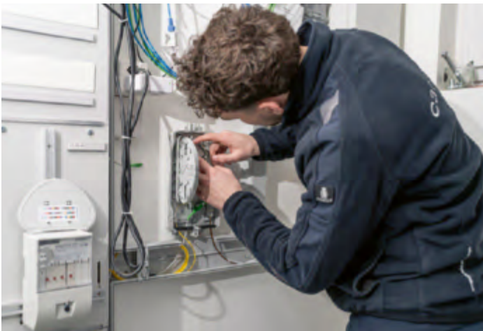
1632 Gebäudeanschlusskästen wurden installiert.
