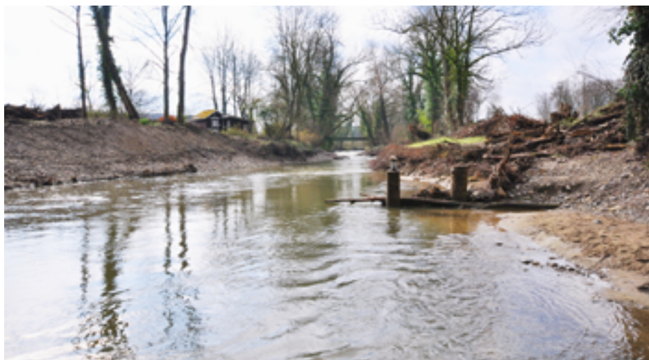
Im Lochergrien nach dem Rückbau. Die Suhre fliesst heute ungehindert.
