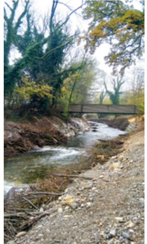
Stabile Sohle durch kleinere Blockschwelen, lebendigeres Ufer dank einer Mischung aus lebendem Material und Totholz.
