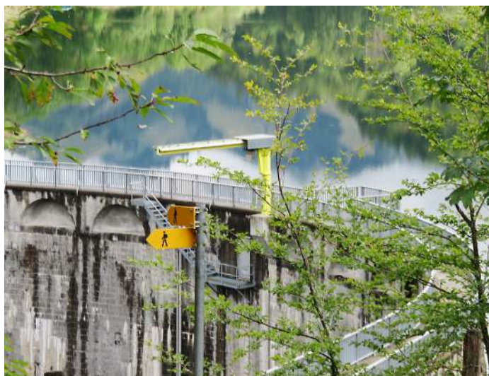
Staumauer Lac de Montsalvens.
